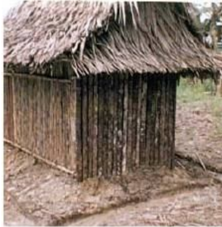
Ilustración N° 8: Exterior de una instalación rustica con paredes y techo de palmera.
